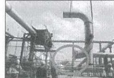
ต้องมีเชือกสำหรับบังคับทิศทางและ ป้องกันการแกว่งตัวของอุปกรณ์ในการยก/เคลื่อนย้ายด้วยทุกครั้ง
